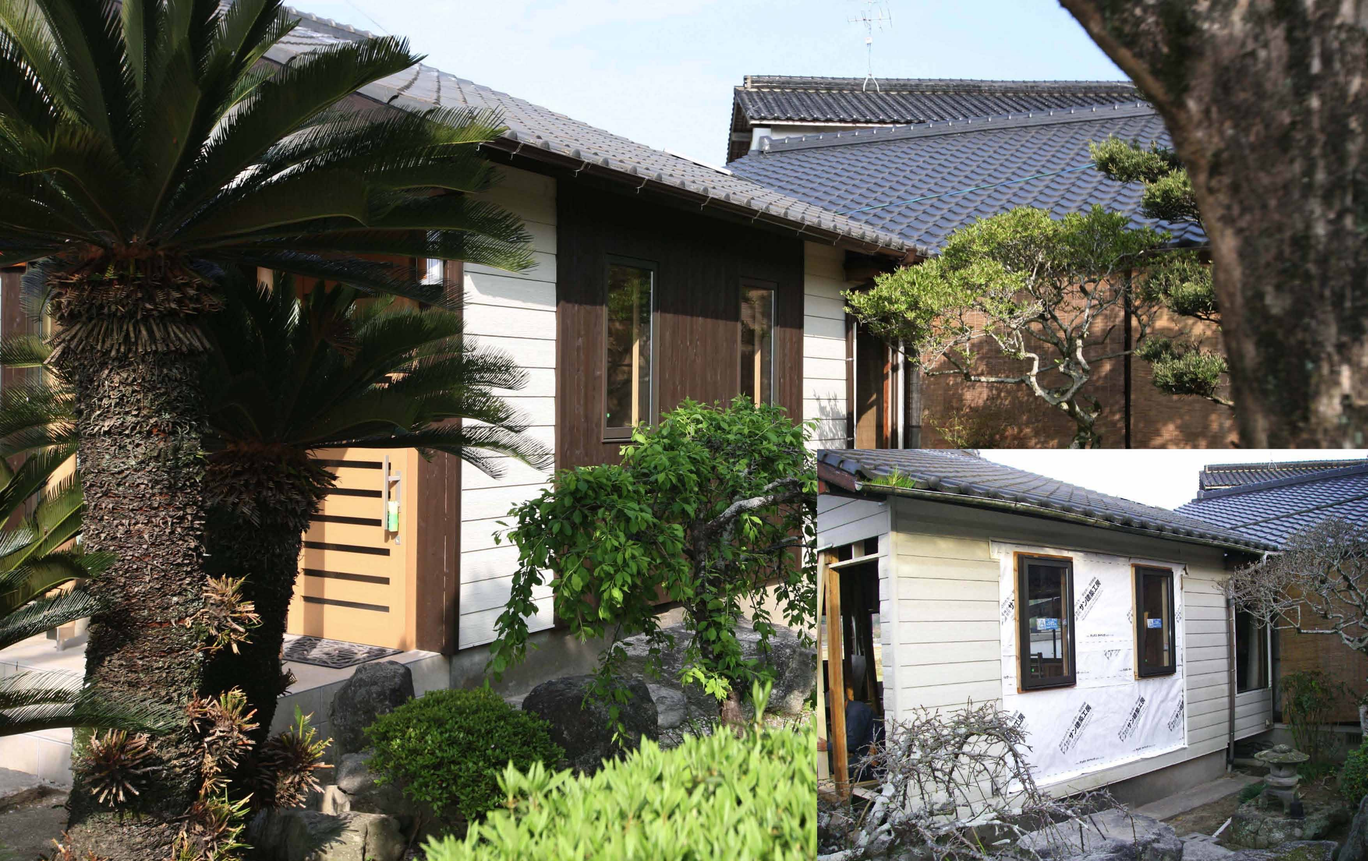
(上) 外壁の補修前と補修後の様子。防水処理を行った後に杉板を貼り、キシラデコールでカラーリングを行った。 (下左) ロフトからLDKを眺めた様子。昔からの梁をデザインとして残した。(下右) 子供部屋の様子。奥に見える収納の建具と建具の間に見える柱は奥様が幼少のころに背の高さを記録していた柱。
